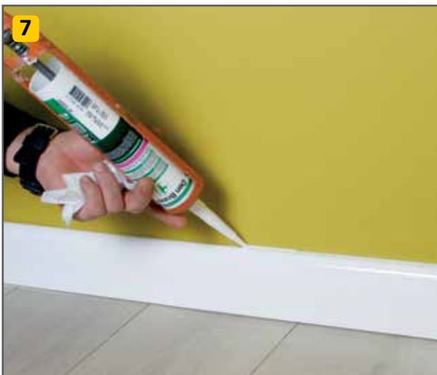
7 Wypełnienie szczelin między ścianą a listwą akrylem. Заполнение щелей между стеной и плинтусом акрилом. Filling the gaps between the wall and the skirting board with acrylic.
