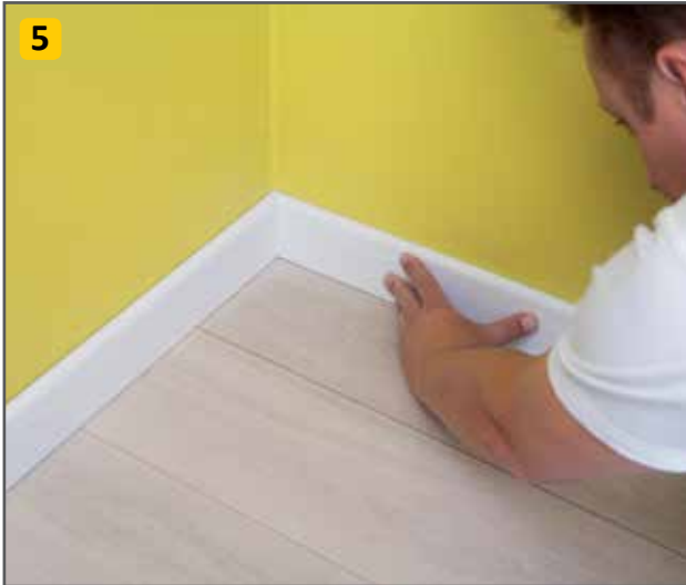
5 Mocowanie kolejnych elementów listwy do ściany. Крепление последовательных элементов плинтуса к стене. Attach the next skirting board to the wall.
