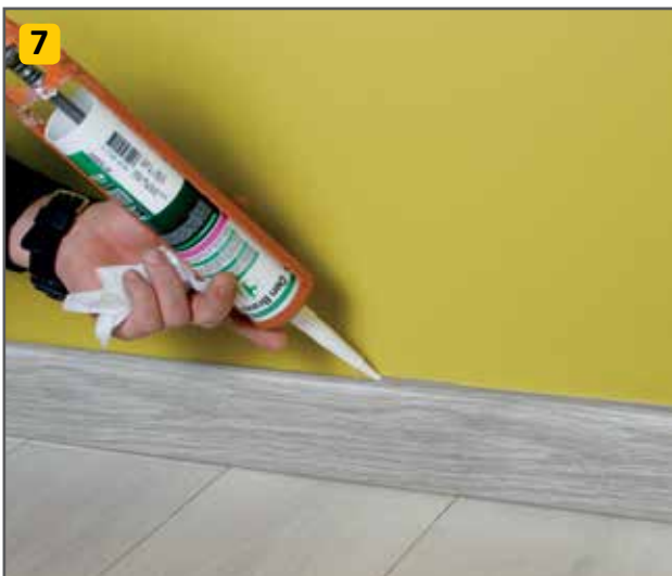
7 Wypełnienie szczelin między ścianą a listwą silikonem w kolorze pasującym do listwy. Заполнение щелей между стеной и плинтусом силиконом подходящего цвета. Filling the gaps between the wall and the skirting board with silicone whose colour matches the skirting board.
