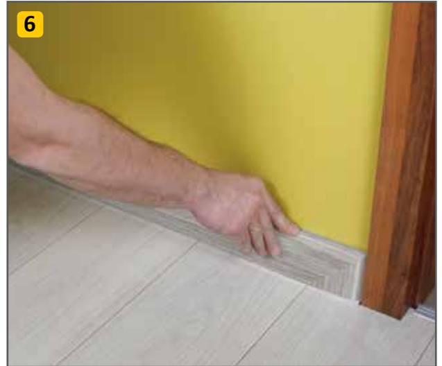
6 Mocowanie listwy przy futrynie. Крепление плинтуса к дверной коробке. Mounting the skirting board to the door frame.
